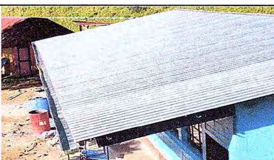
Foto 4: FINALIZACIÓN DE TECHO PARA EL MÓDULO 1.
