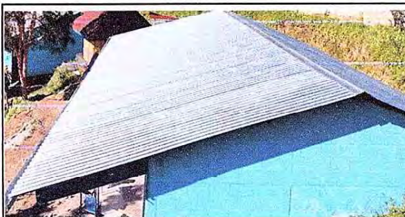
Foto 15: FINALIZACIÓN DE COLOCACIÓN DE TECHO, MÓDULO 1.
