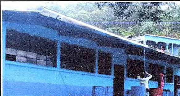
Foto 14: VISTA FINAL DEL CAMBIO DE TECHO (LAMINA CAPOTE Y CANALES), MÓDULO 1.
