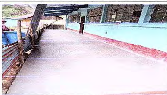
Foto 2: FINALIZACIÓN DE ENTORTADO DE CEMENTO FRENTE AL MÓDULO 2.
