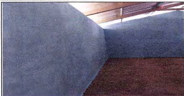
Foto 7: FINALIZACIÓN DE MANTENIMIENTO DE MÓDULO 3.
