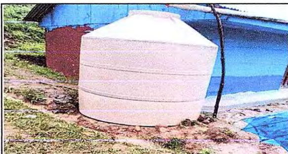
Foto 18: Adquisición de nuevo tinaco y mantenimiento de cisterna.
