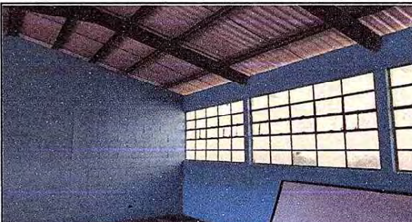
Foto 16: VISTA INTERNA DEL AULA, MÓDULO 1.
