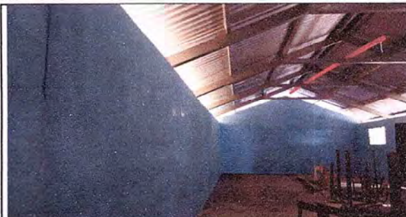
Foto 8: FINALIZACIÓN REPELLO, PISO Y PINTADO, MÓDULO 3.
