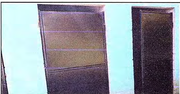
Foto 5: PUERTAS DE BAÑOS, MÓDULO 4.
