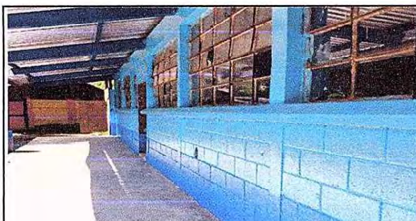
Foto 17: VISTA FINAL DE AULAS TECHO, PISO ALISADO Y CORREDOR, MÓDULO 1.
