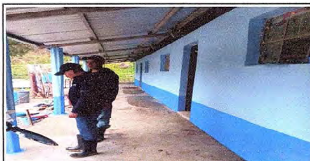
Foto 9: VISTA DEL MÓDULO 3 FINALIZADO.
